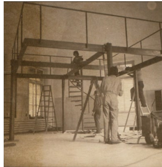
Einbau der Emporen
